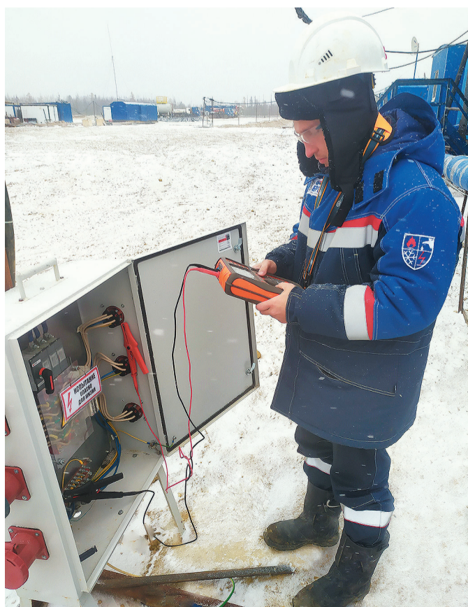
Измерение сопротивления изоляции кабелей на производственном объекте ООО «БНГРЭ». Куюмбинский лицензионный участок
