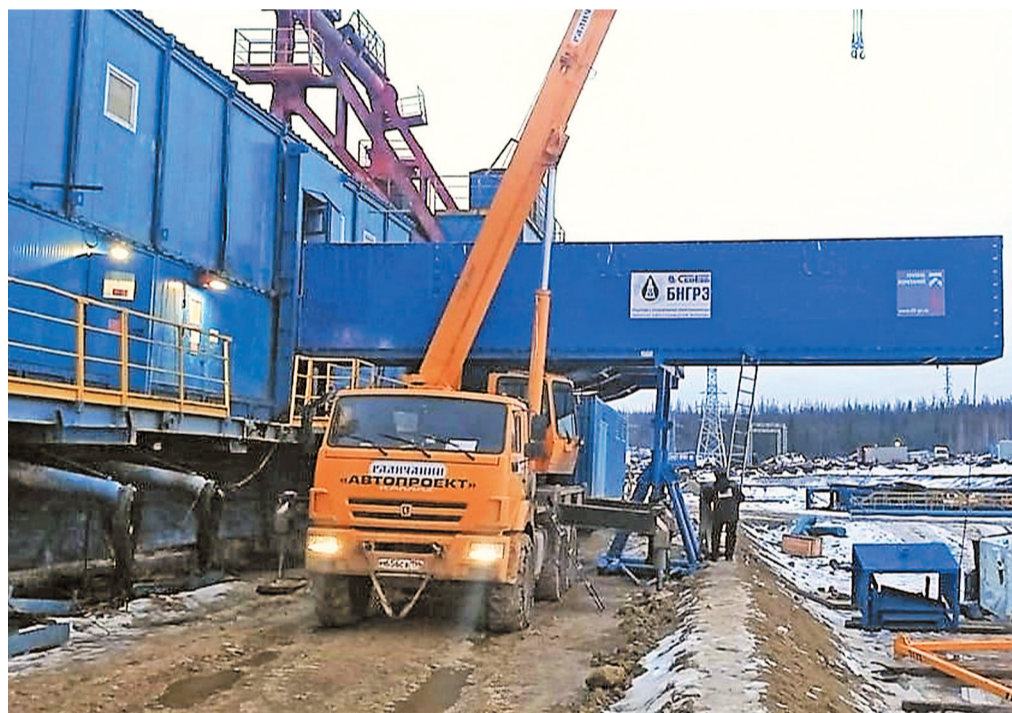
Монтаж наружной секции ленточного транспортера на КП-116. Курумбинский лицензионный участок
